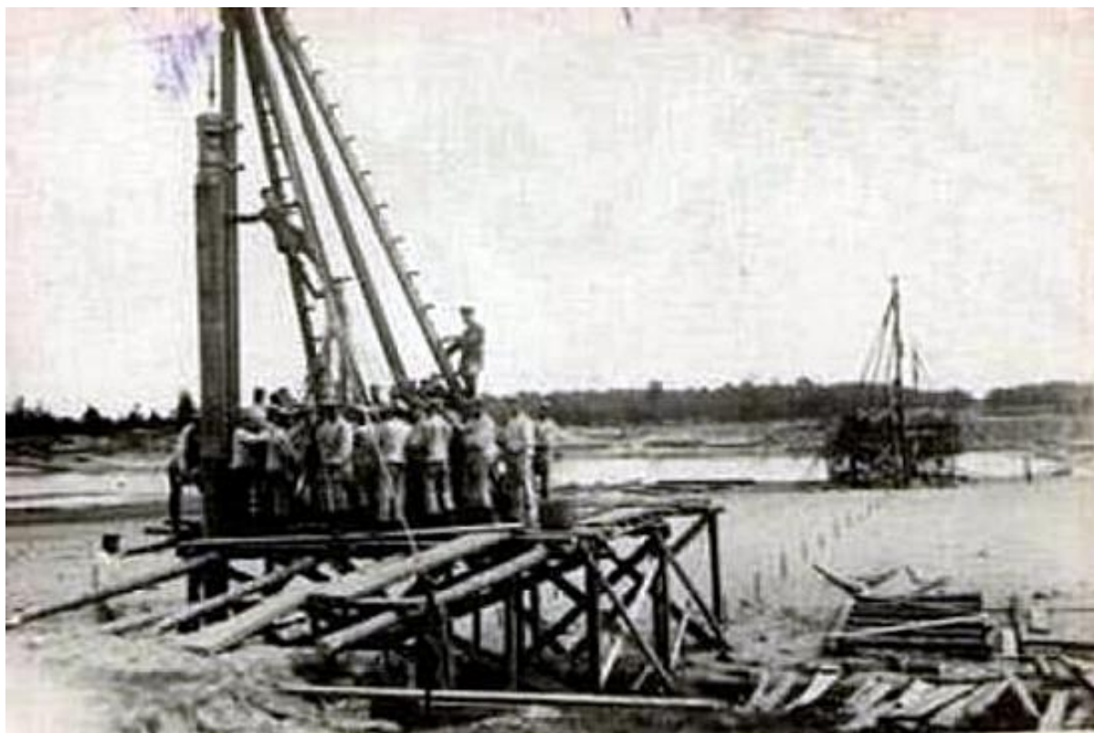
Niemieccy saperzy podczas budowy mostu drewnianego na rzece Narew na wąskotorowej linii Wielbark – Ostrołęka, 1915 r., fot. ze zbiorów autora.
